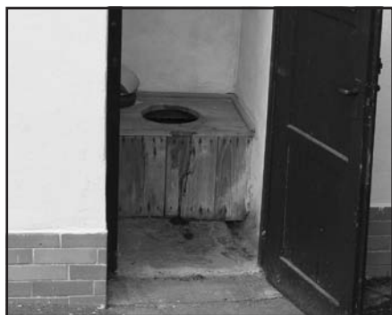
WC hřbitov – před rekonstrukcí
