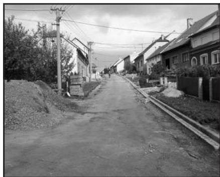
Rekonstrukce komunikace ul. 28. října
