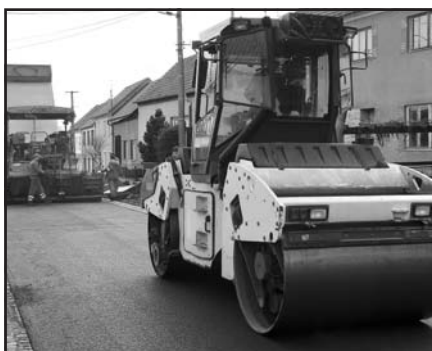
Rekonstrukce komunikace ul. 28. října
