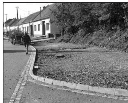
Rekonstrukce parkoviště Araver
