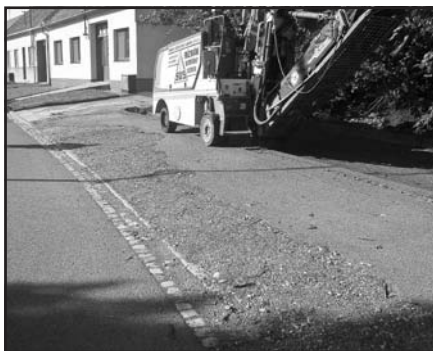
Rekonstrukce parkoviště Araver
