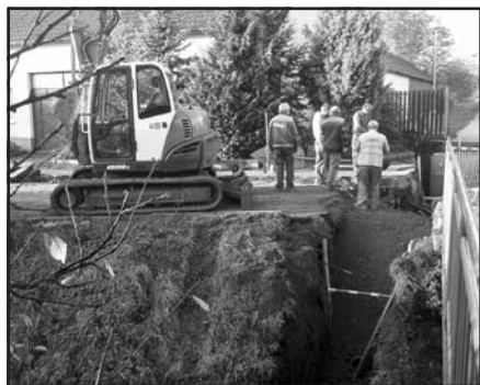
Kanalizace ul. 28. října
