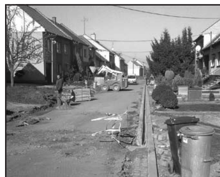
Rekonstrukce komunikace ul. 28. října
