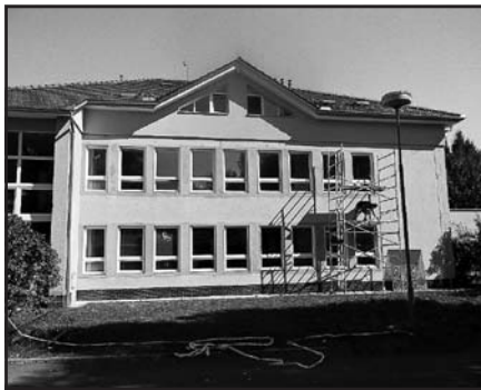
Výměna oken MŠ
