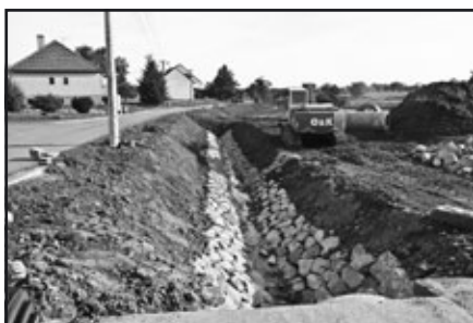
zkapacitnění vodoteče Panské
