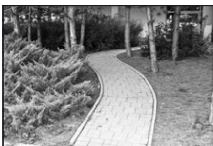
zbudování bezbariérového přístupu do ZŠ
