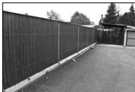
Budování nového plotu na dvorku za měšťankou
