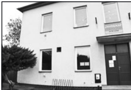
nátěry všech oken v budově Zahrádkář
