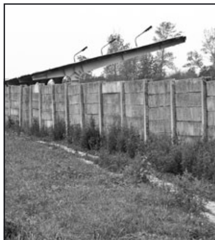
zahájení rekonstrukce sportovně rekreačního areálu Vlčnov
