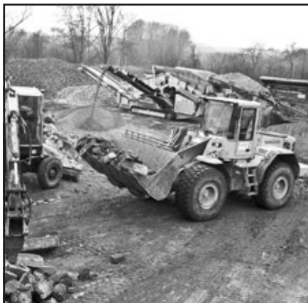
zřízení skládky stavební sutě a využití drce- ného recyklátu pro zpevnění obecních cest
