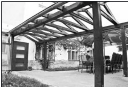
úprava dvora obecního úřadu, zastřešení přístupu k WC
