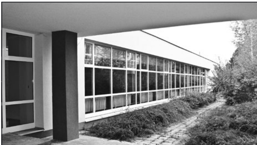
zateplení čtyř pavilonů ZŠ, nový povrch střechy, výměna všech oken a vstupních dveří
