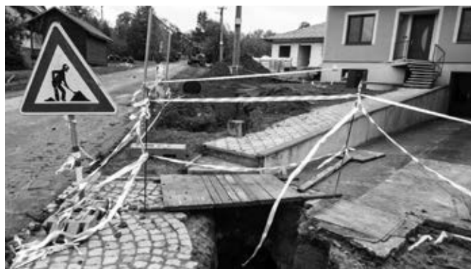
Budování inženýrských sítí v ulici Vinohradská
