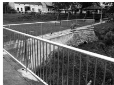
Nové zábradlí u vodoteče Na Rybníčku
