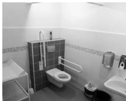
Bezbariérové WC v ZŠ
