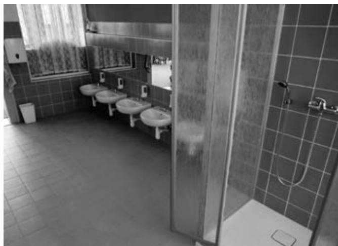
Rekonstrukce sociálního zařízení v MŠ
