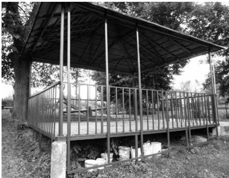
Oprava altánku Na Rybníčku
