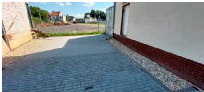
Oprava části plochy na stadionu.
