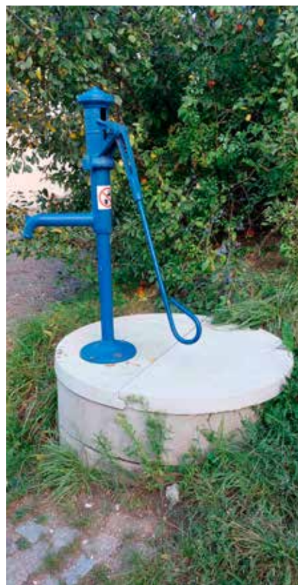
Opravená pumpa v ulici Starohorská.
