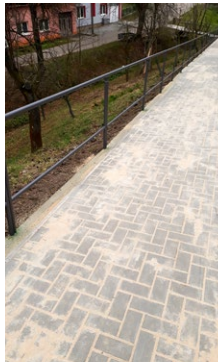
Chodník Vala-Rybáře, po rekonstrukci
