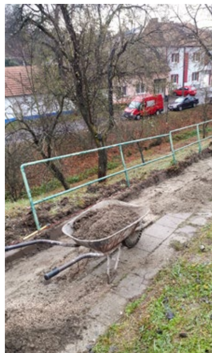
Chodník Vala-Rybáře, průběh rekonstrukce
