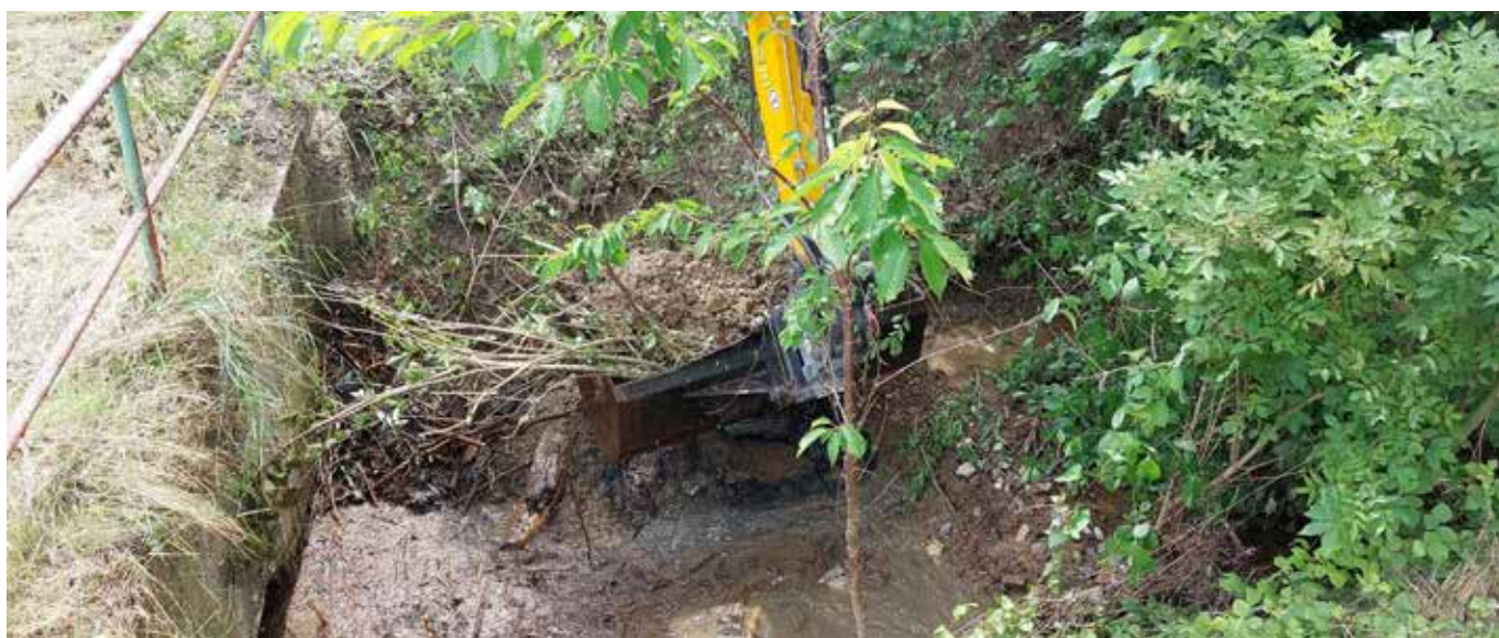
Čištění potoka u koupaliště
