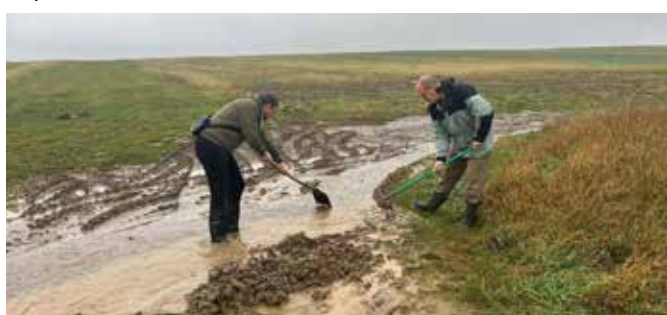
Čištění odvodnění během soboty 14. 9.
