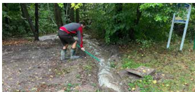
Čištění odvodnění během soboty 14. 9.
