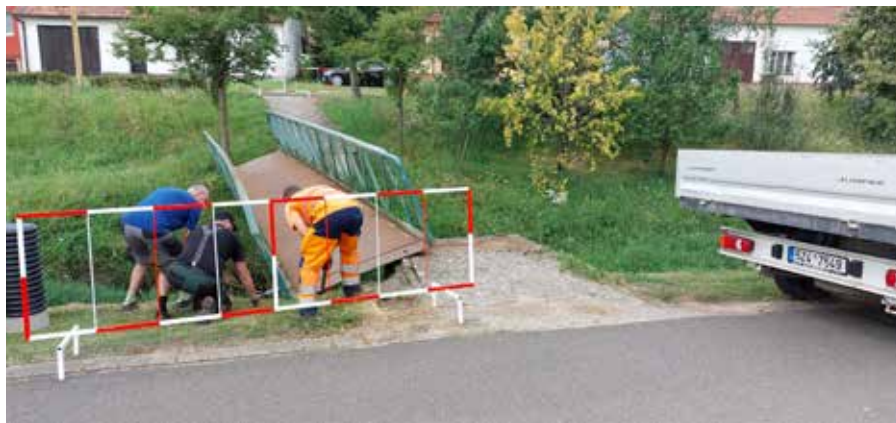
Demontáž staré lávky na dolním konci
