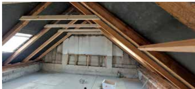
Opravená střecha Zahrádkář
