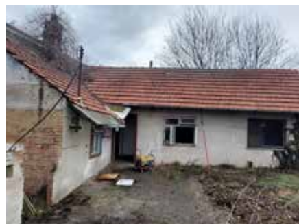
Dům před demolicí
