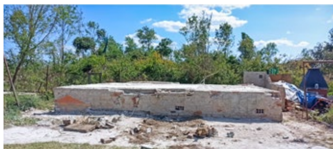
Sklepní část domu v Lužičích – úkol vlčnovských hasičů při 4. výjezdu 11. 7.
