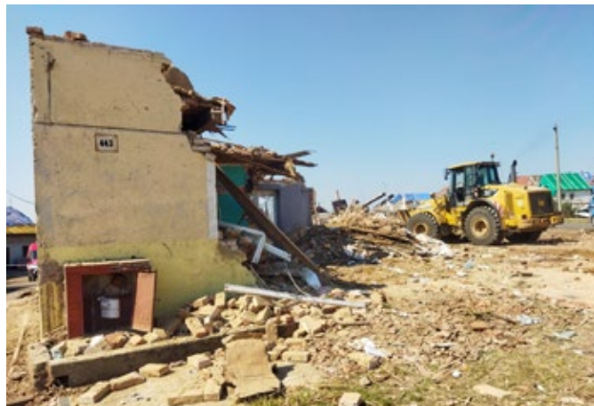
1. výjezd vlčnovských hasičů 29. 6. Mikulčice – bourací práce rodinného domu č. 443
