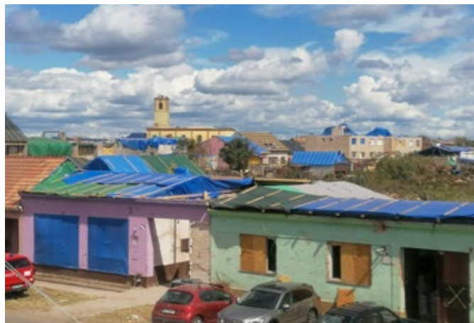
2. výjezd vlčnovských hasičů 1. 7. – Moravská Nová Ves – pohled na část obce a kostel z půdy rodinného domu – bourací práce
