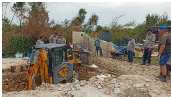
Bourání sklepní části domu za pomoci účinné techniky Marka Dacíka, Lužice
