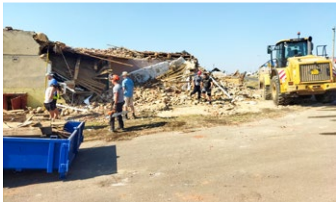
1. výjezd vlčnovských hasičů 29. 6. Mikulčice – bourací práce rodinného domu č. 443
