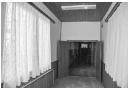
Celkový pohled na nově zacloněný výhled z oken
