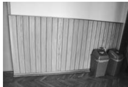
Nový obklad stěny po odstranění nefunkčního topení
