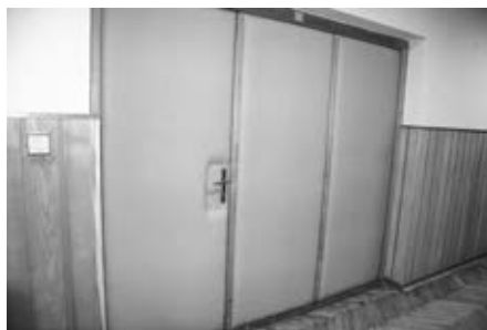
Nové čalounění vstupních dveří do sálu
