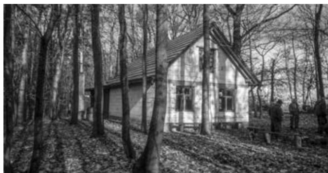
Myslivecká chata po rekonstrukci
