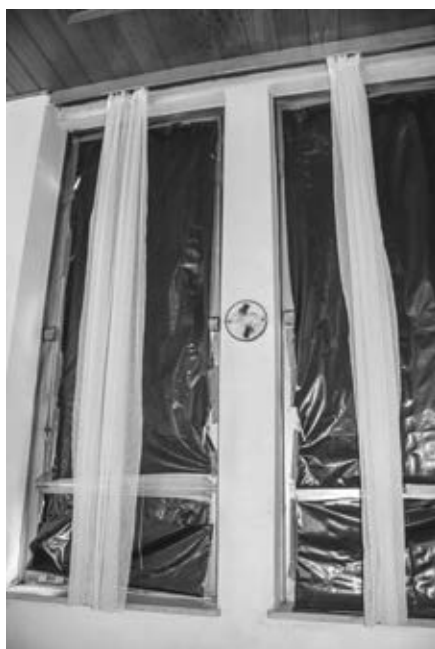
Okna na balkoně a původní stav jejich zatemnění
