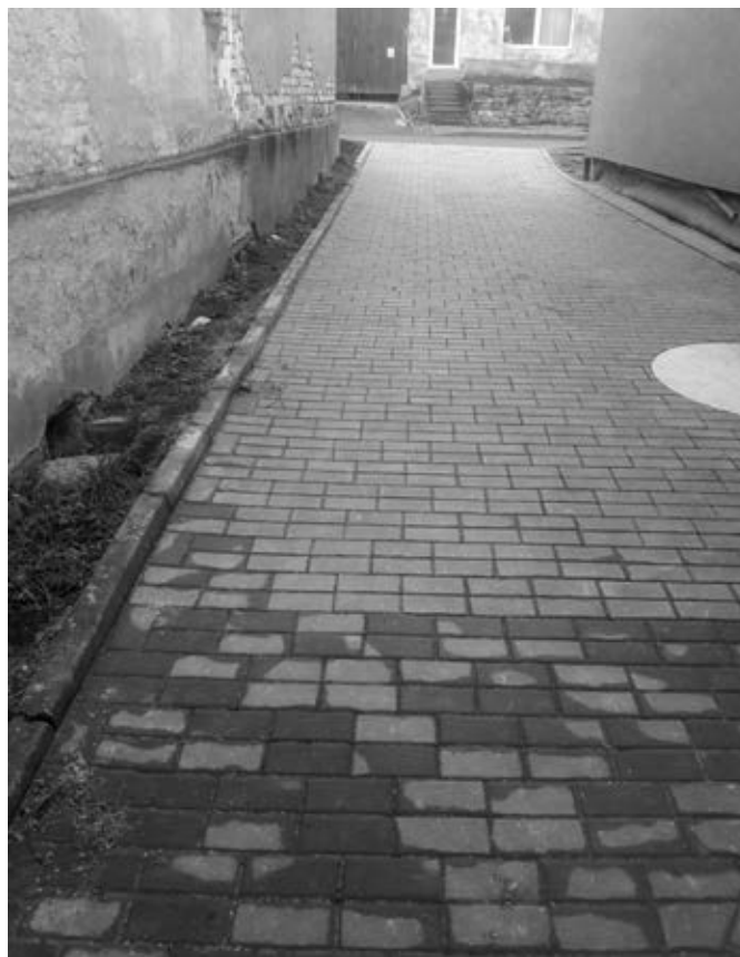
Oprava chodníku pod dolním obchodem do ul. Pod Bočky
