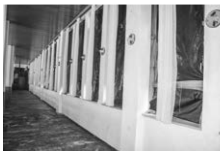
Balkon – oprava podlahy
