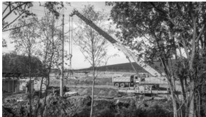
Koupaliště – ukládání kanalizační šachty
