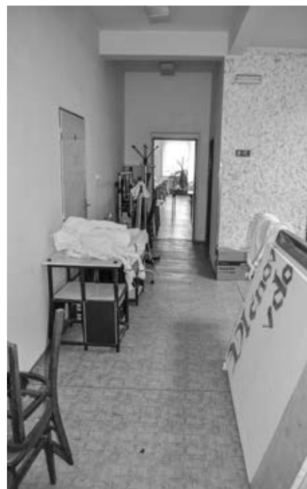
Chodba v patře – původní stav
