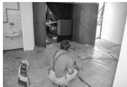
Šatna pro účinkující – oprava podlahy
