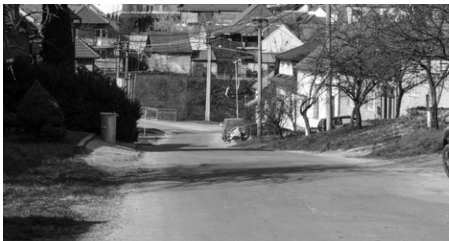
Silnice v ul. Podedvorská před rekonstrukcí
