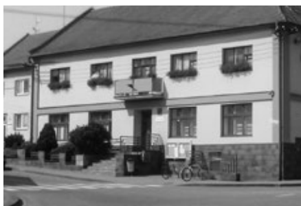
Budova obecního úřadu před opravou
