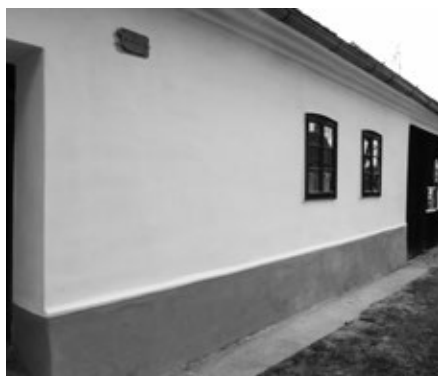
Odborná oprava fasády domu č. 65
