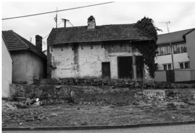
Poslední foto již zbořeného domu č. 191
