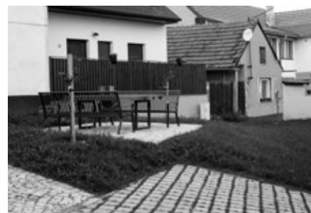
Dolní chaloupky po rekonstrukci
