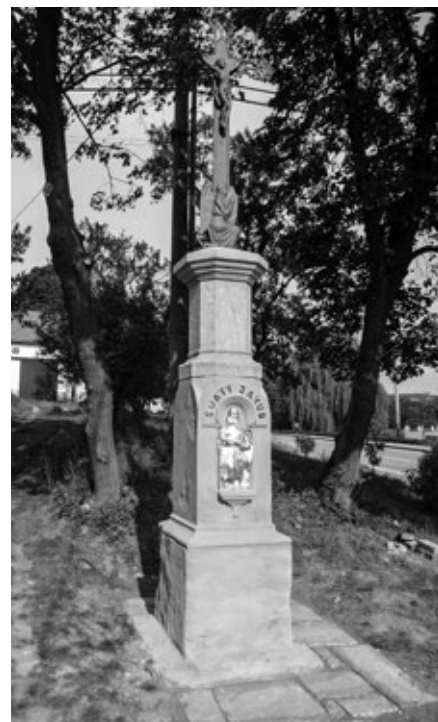
Kříž sv. Jakuba po rekonstrukci
