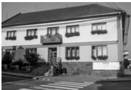
Budova obecního úřadu po opravě
