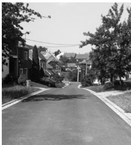
Silnice v ul. Podedvorská po rekonstrukci
