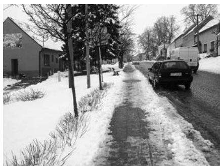
Parkování před rekonstrukcí
