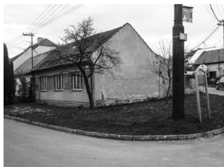
Poslední pohled na dům čp. 364, dnes již zbořený
