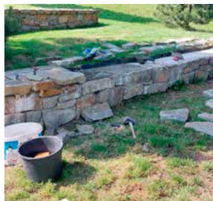
Oprava teras na koupališti
