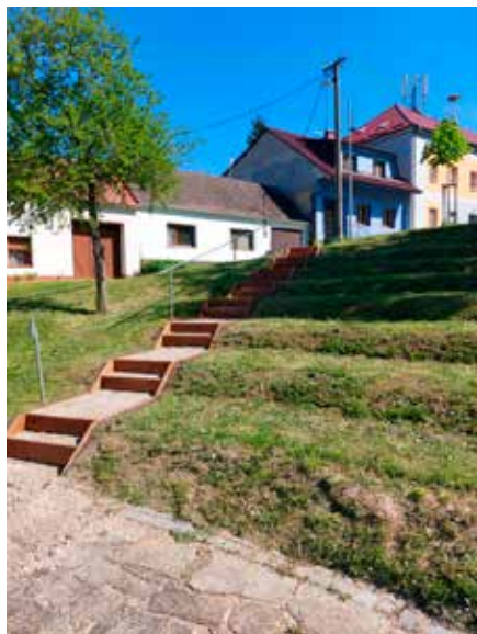
Nové schody v amfiteátru
