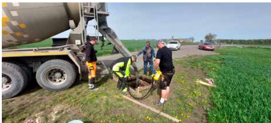
Betonování základu pomníku
