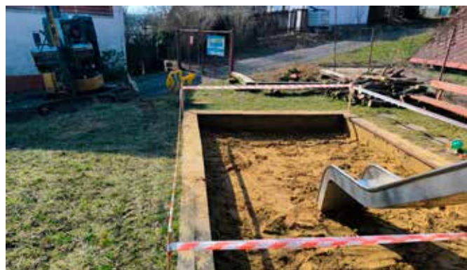
Obnova pískovišť na dětských hřištích
