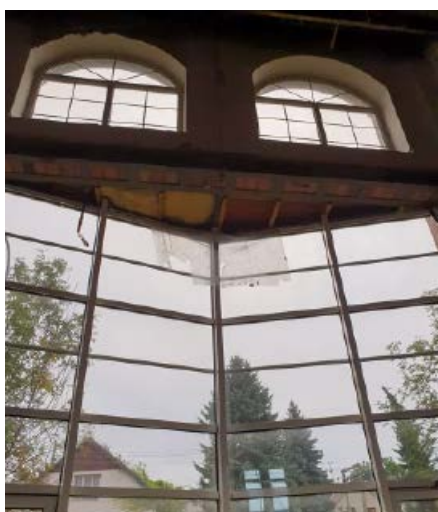
Původní okna v sále
