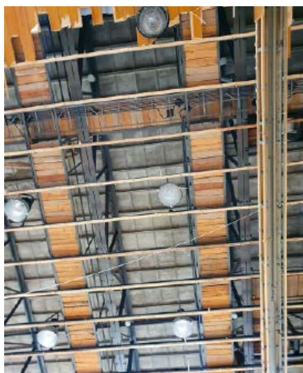
Demontáž stropu a světel
