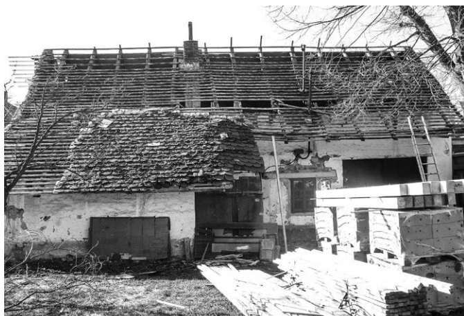
Klubovna včelařů před rekonstrukcí
