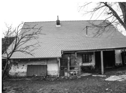
Po rekonstrukci střechy
