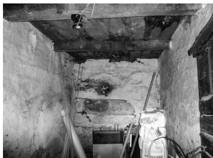
Interiér před rekonstrukcí
