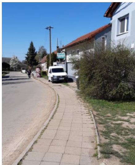
Chodník před rekonstrukcí
