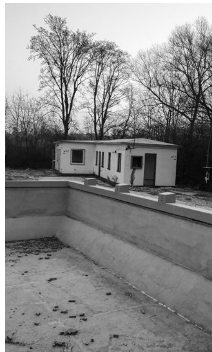
Koupaliště před rekonstrukcí, bufet před demolicí
