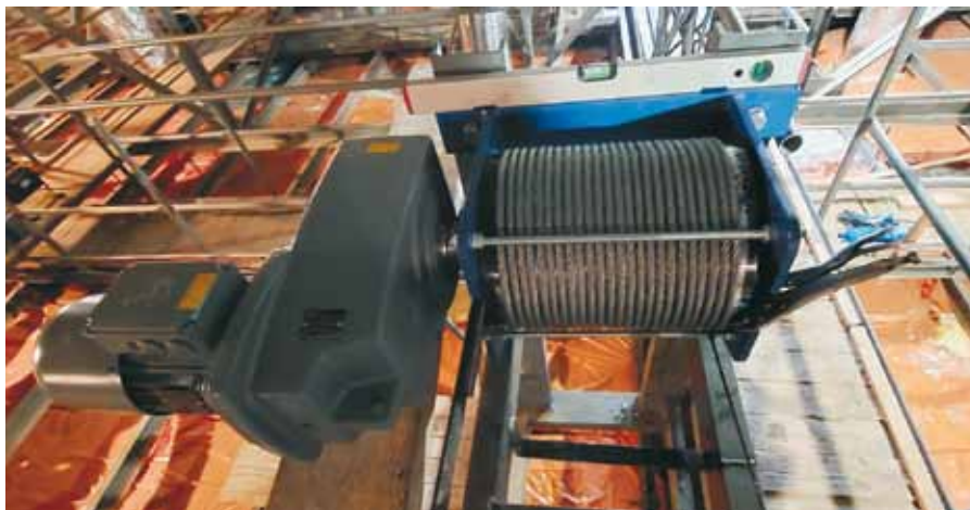
Oprava zdvižného zařízení pódia v KSK.
