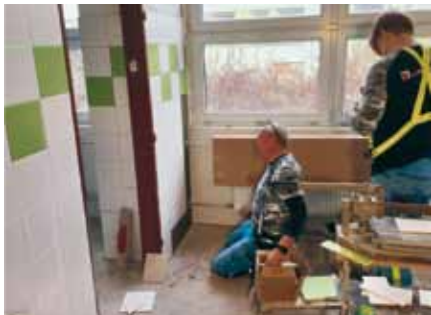
Rekonstrukce 1. stupně ZŠ.
