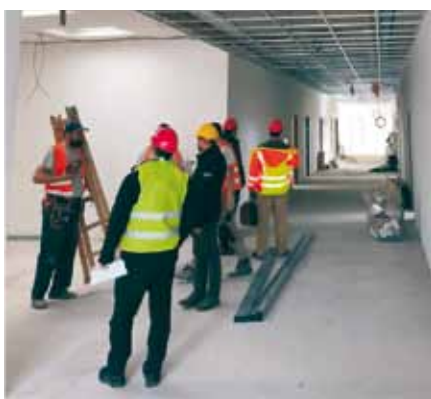
Rekonstrukce 1. stupně ZŠ.
