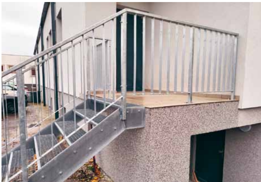
Nové schodiště do přisálí KSK.
