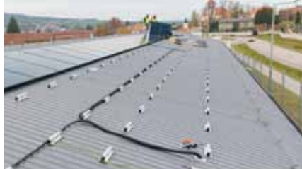
Montáž fotovoltaických panelů na tribuně stadionu TJ.
