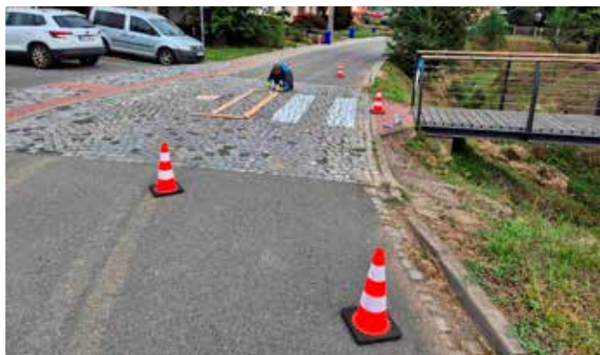
Nátěr přechodu k ZŠ
