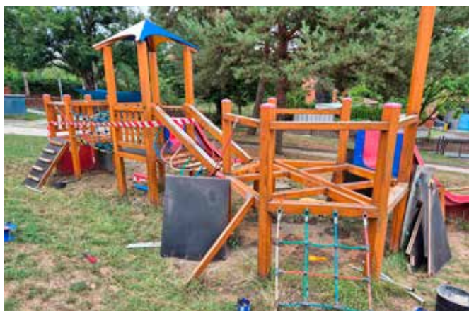
Oprava herních prvků ve školce
