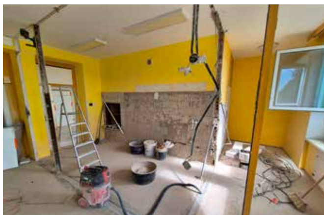
Třída MŠ průběh rekonstrukce
