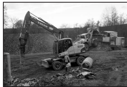
Drcení stavební suti
