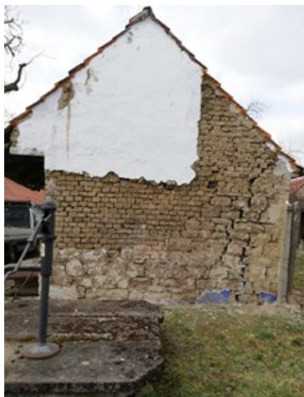
Roh domu bude nutné nově podezdít na kámen a vápenotrasovou maltu, nově vyzdít stěny a spojit se současným zdravým zdivem
