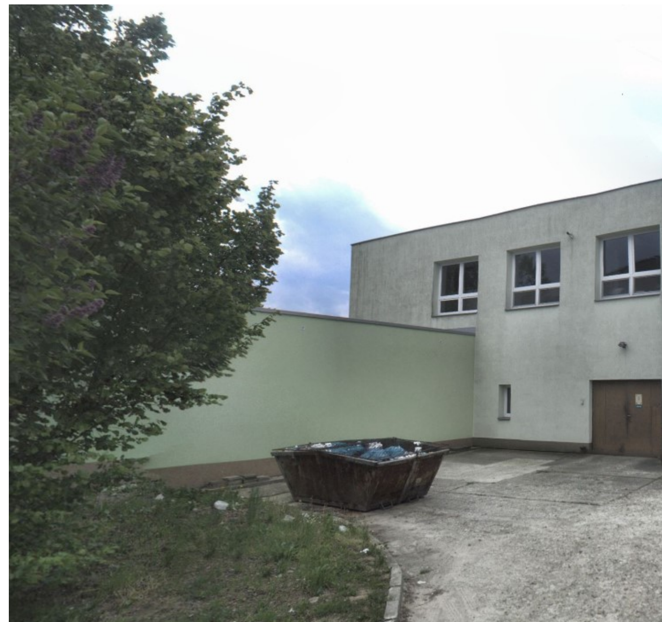
Stávající pavilon D základní školy – dílny, školní kuchyně
