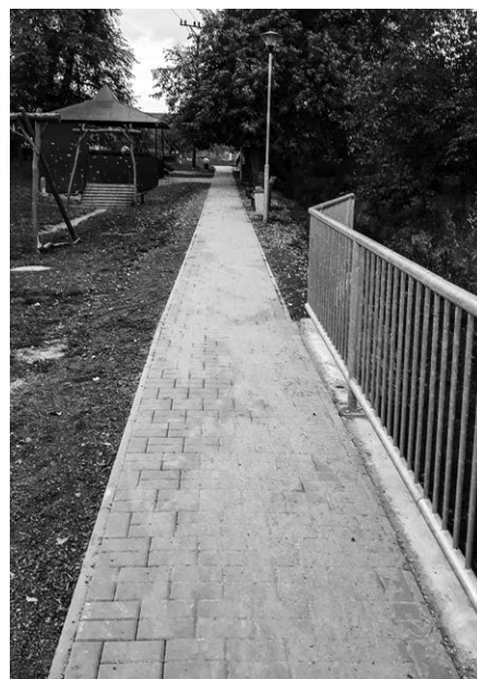
Rekonstrukce chodníku Na Rybníčku
