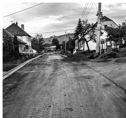
Ulice Záhumní v rekonstrukci
