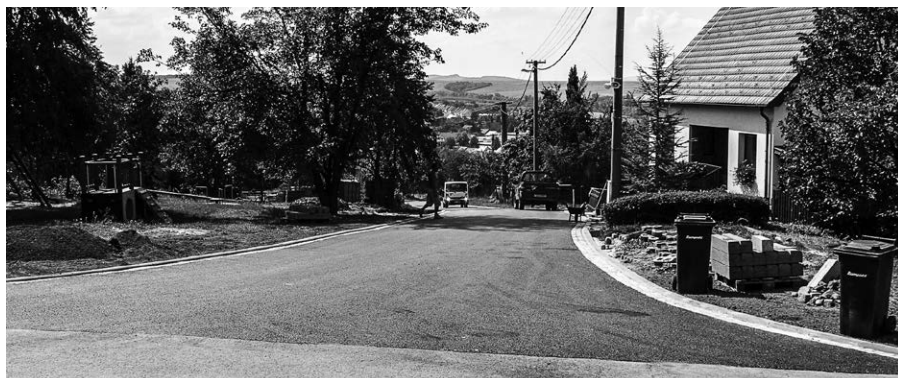
Nová silnice Na Hraničce, horní úsek
