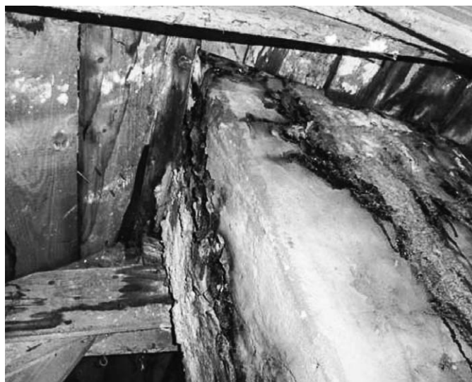
Připojený automatický kotel na jednovrstvý komín. Revizní technik vydal kladnou zprávu bez závad. Spaliny i bez natlakování průduchu unikají mimo dřívo, dřevěné konstrukce jsou pokryty sazí a dehtem právě díky úniku spalin.
