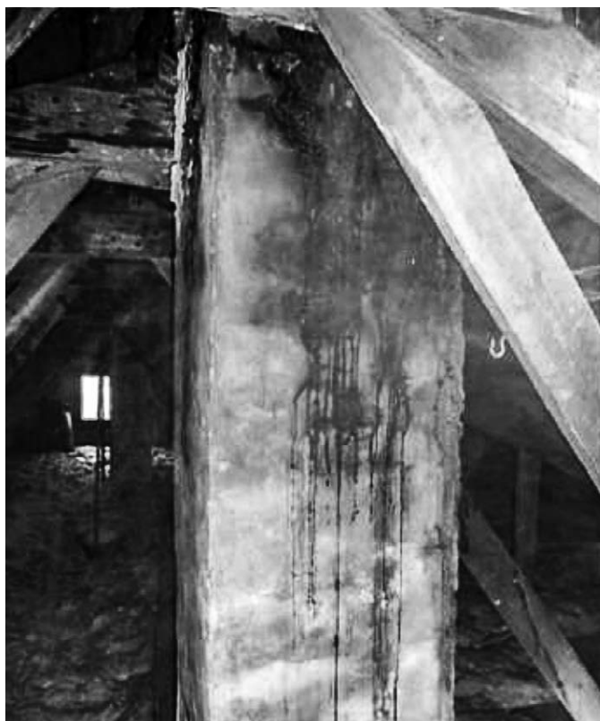
Připojený automatický kotel na jednovrstvý komín. Revizní technik vydal kladnou zprávu bez závad. Spaliny i bez natlakování průduchu unikají mimo dřívo, dřevěné konstrukce jsou pokryty sazí a dehtem právě díky úniku spalin.
